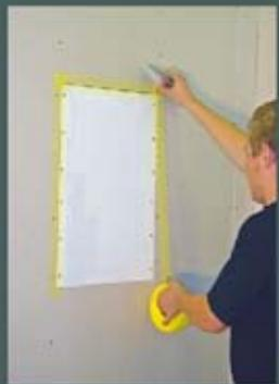
2 Когато стените са готови - затворени със гипс-картон и подходящо обработени, се мащат шаблоните и инсталаторите свързват тонколоните, тестват сигнала и монтират самите тела.
