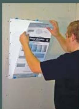
3 Следва точно нивелиране с нивото на стената, облепване на фугите със специална мрежа... тоест подготовка за частична замазка, която покрива монтажните елементи като винтове и фузи като слива тонколоните със стената. На лицевия панел на тонколоните е запазен специален отстъп, с по-ниско ниво, който поема тези подготвителни работи.
